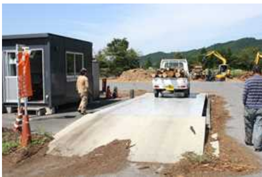
③ 運び込んだ材の計量を行う。
